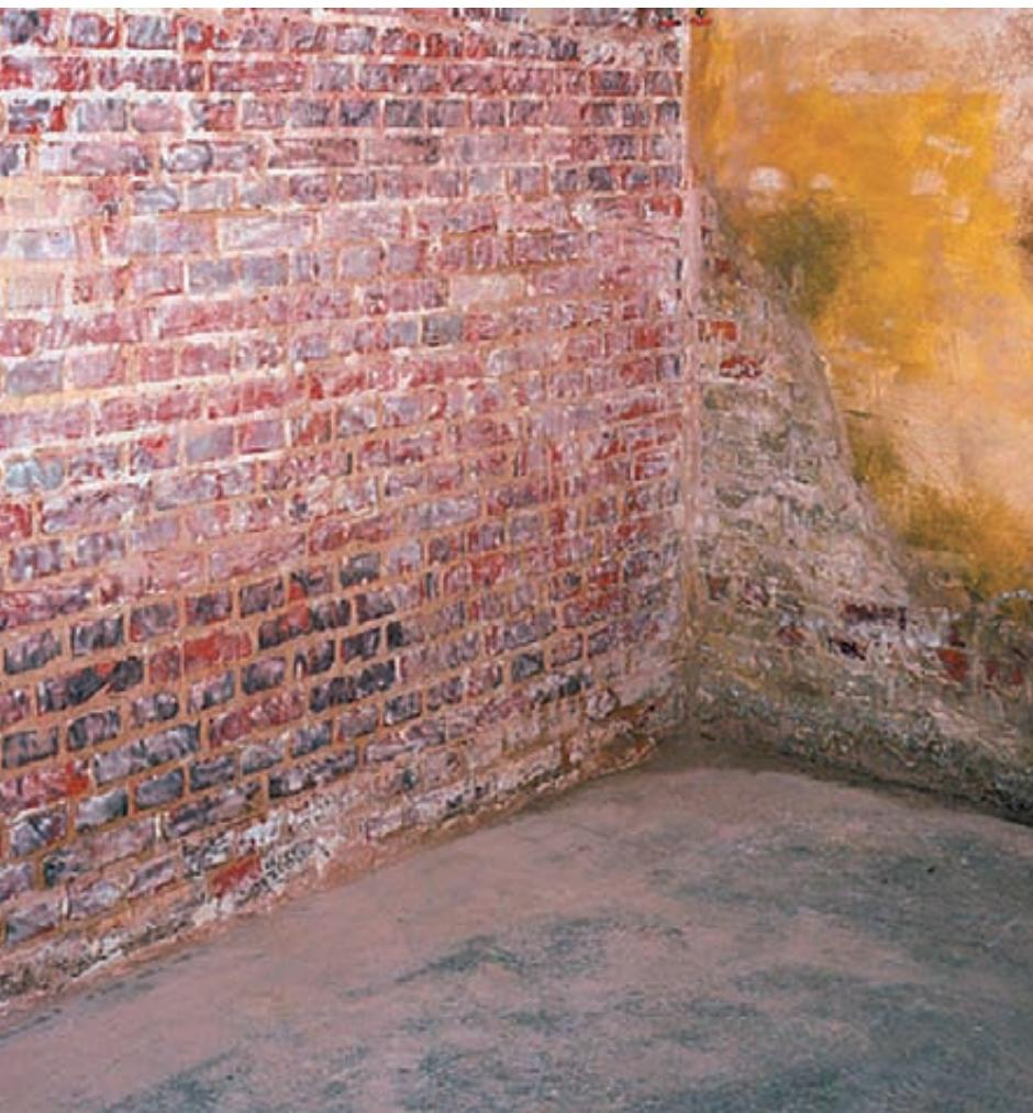
Kapilárně vzlínající vlhkost poškozuje zdivo a omítku. Dodatečná vodorovná izolace Weber.tec 946 nabízí jednoduché a spolehlivé řešení.
